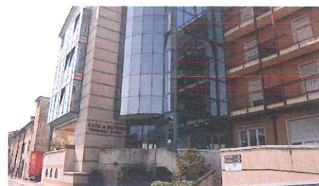
Gli esterni della casa di riposo Morelli Bugna: il Cda ha davanti quasi due anni di lavoro
